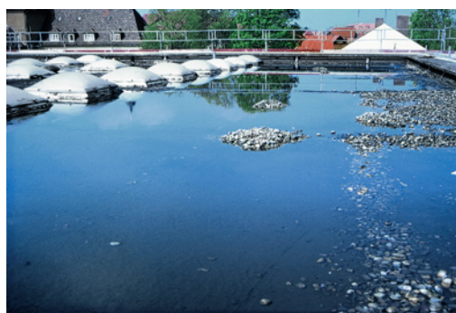
Abb. 3.1 Stehendes Wasser auf einem 0°-Dach
