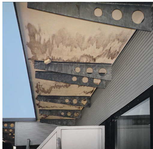
Abb. 7.2 Verfärbungen einer Dach- unterseite aus BFU-Platten
