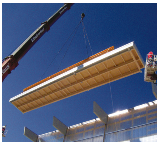
Abb. 4.9 Montage Dachelement einer Industriehalle
