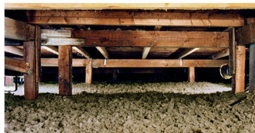
Abb. 3.8 Belüftetes Flachdach, gleichmäßig gedämmt mit Steinwollegranulat
