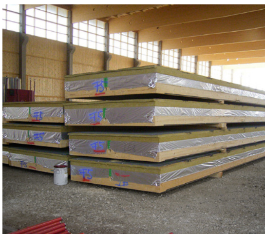
Abb. 4.10 Zwischenlagerung der Dachelemente
